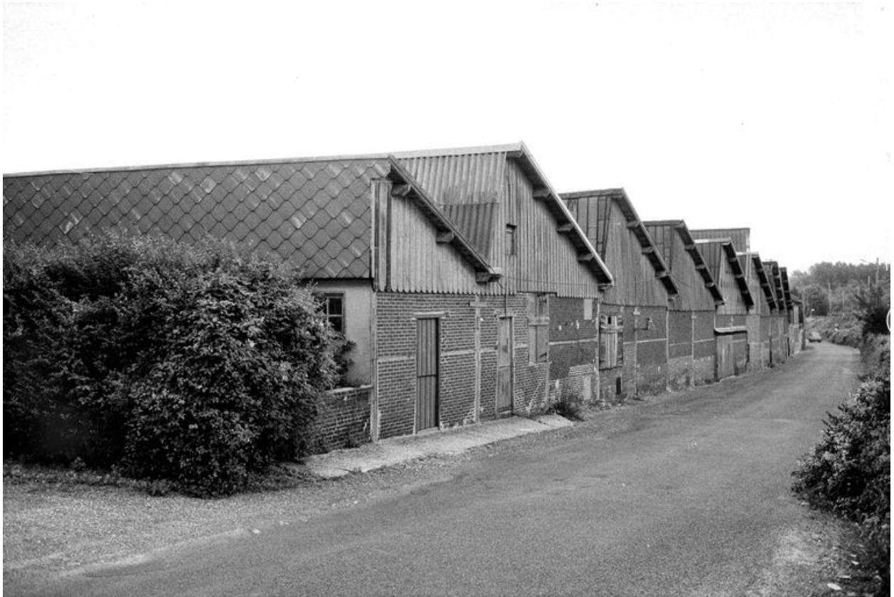
Enfilade des ateliers en sheds le long de la rue de la rue Pierre et Marie Curie (détruits).
