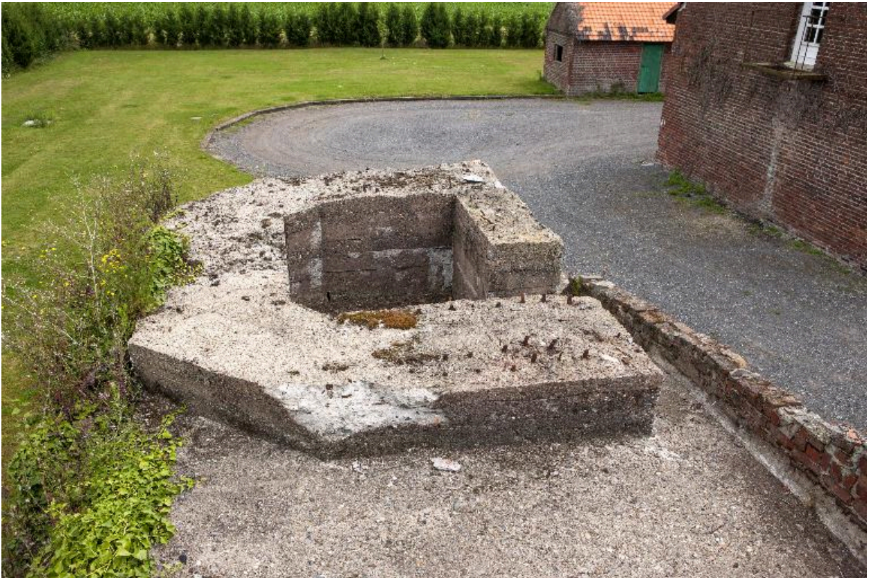
Poste d'observation depuis le couverture de la casemate, vers le sud-ouest
