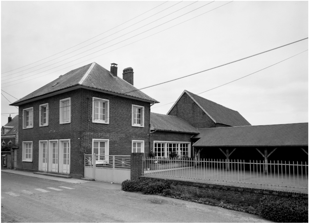
Vue d'ensemble ouest.
