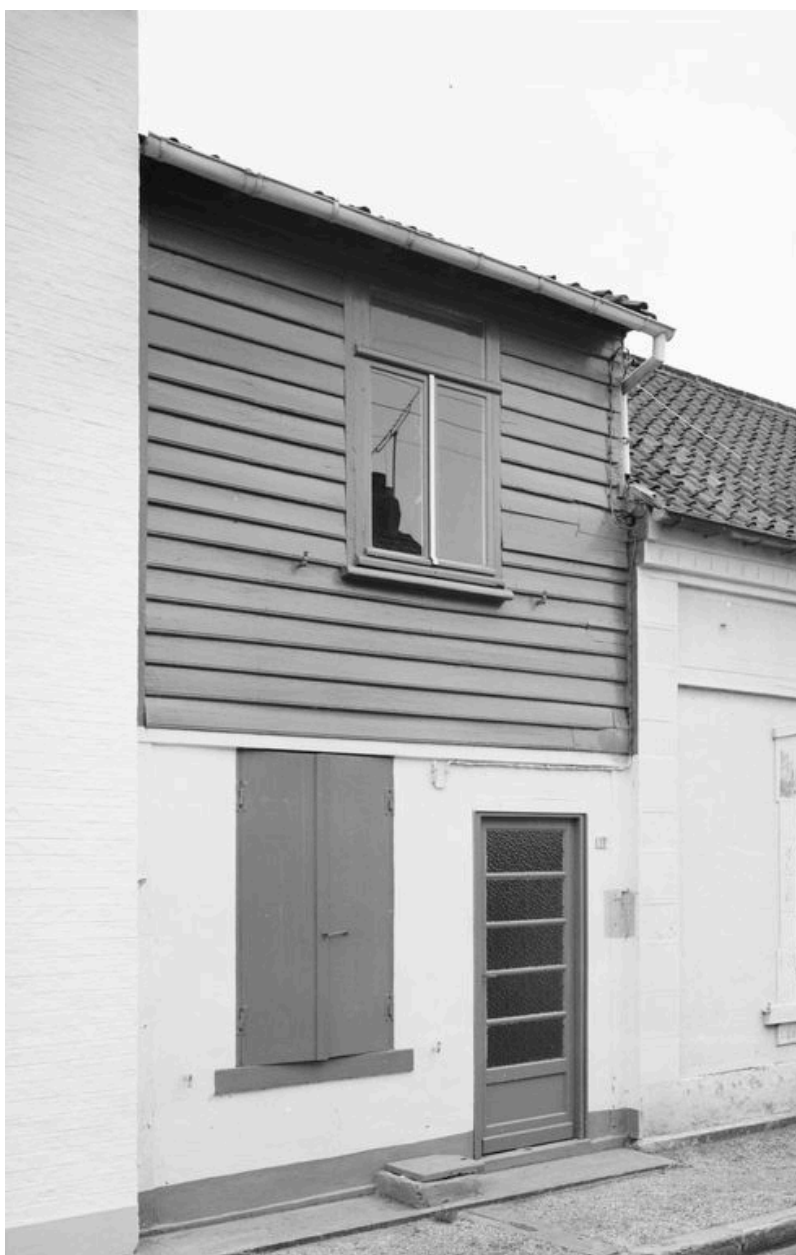
Elévation antérieure d'une maison de pêcheur.
