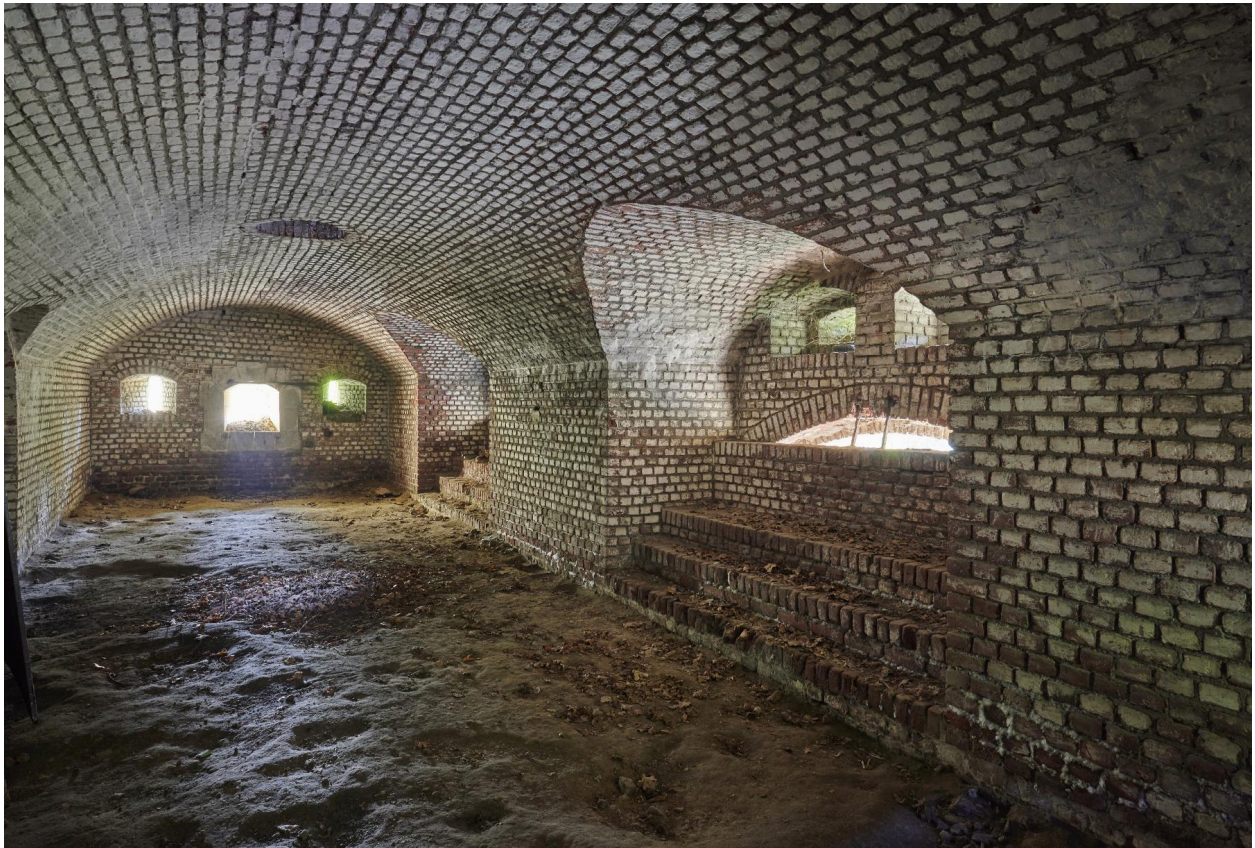
Aile ouest. Caponnière simple. Chambre de tir et meutrière à grenades (à droite).
