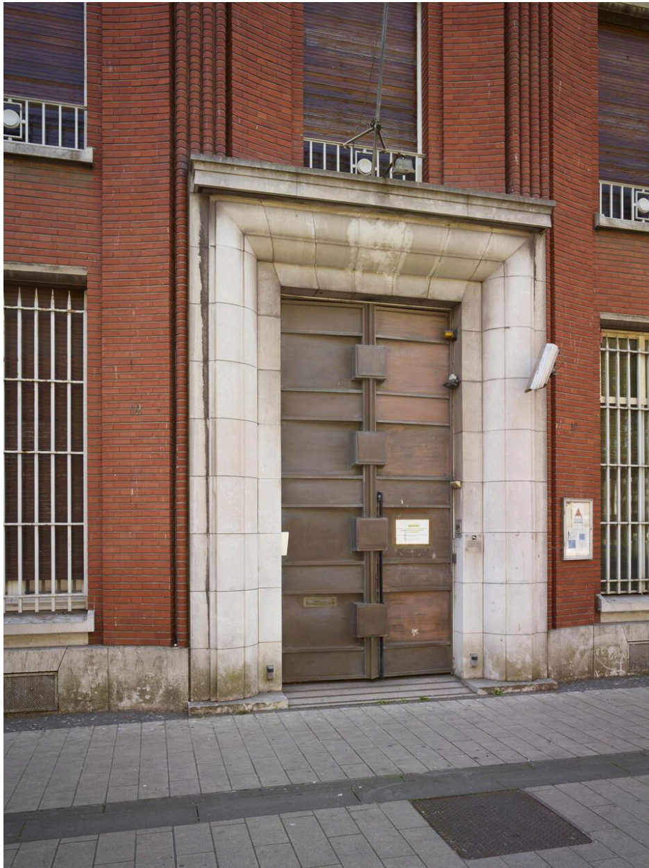
Vue de la porte d'entrée place Jean-Bart.
