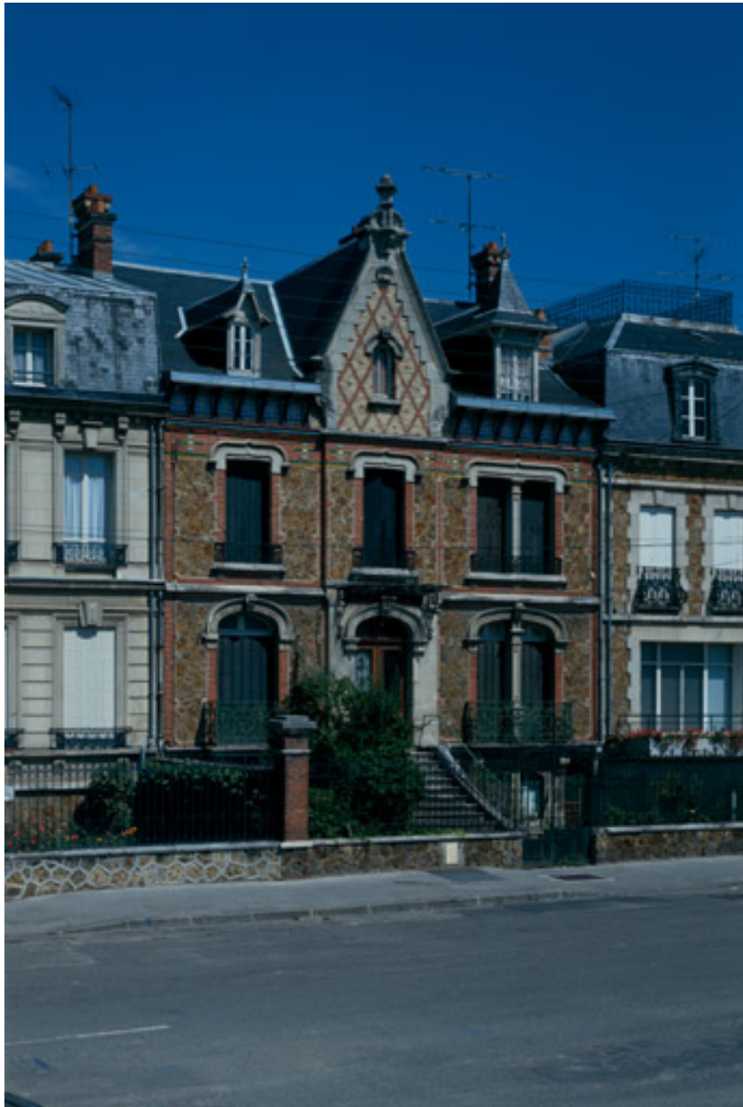
Vue générale depuis la place.
