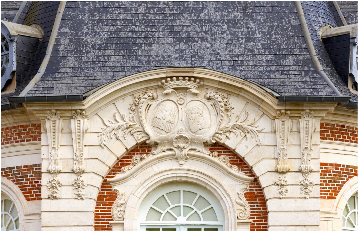
Détail des armoiries sculptées au fronton cintré de l'avant-corps de la façade sur cour.
