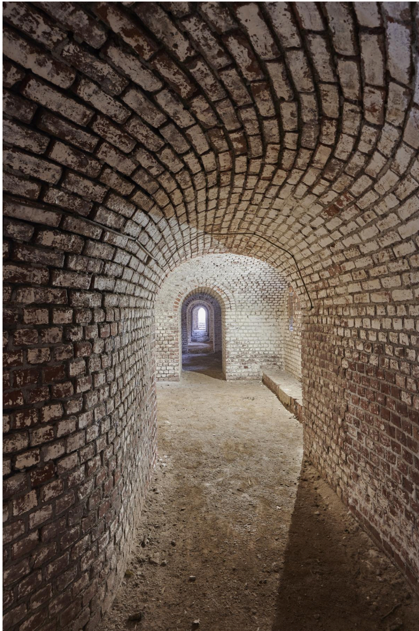
Couloir reliant les casemates de flanquement de la caponnière double.
