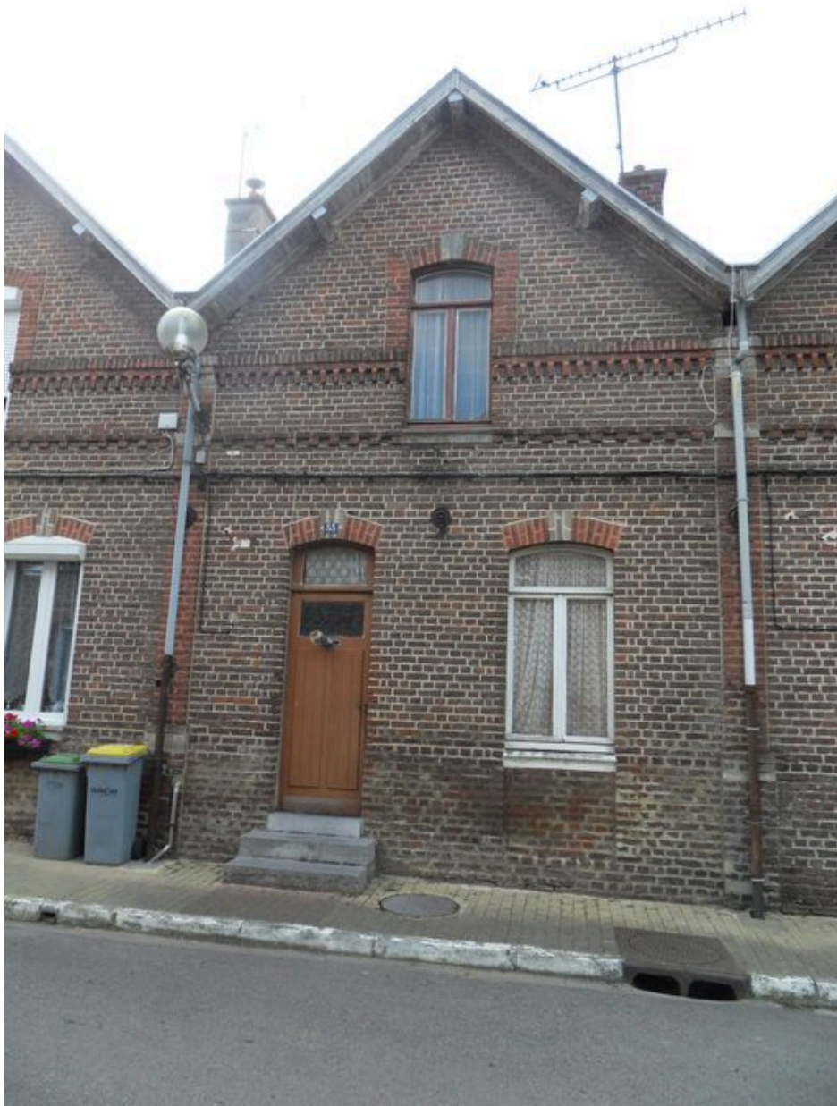
Vue de la façade antérieure d'un logement.
