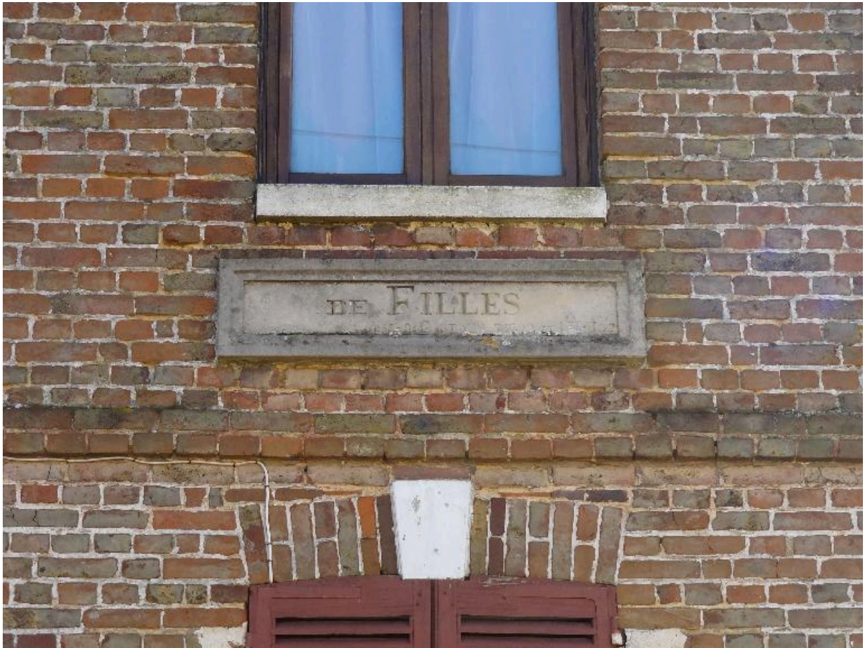
Cartouche de la travée ouest de l'ancienne école de filles ( DE FILLES)
