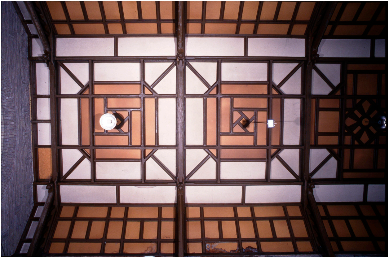
Détail de la charpente apparente de la nef.
