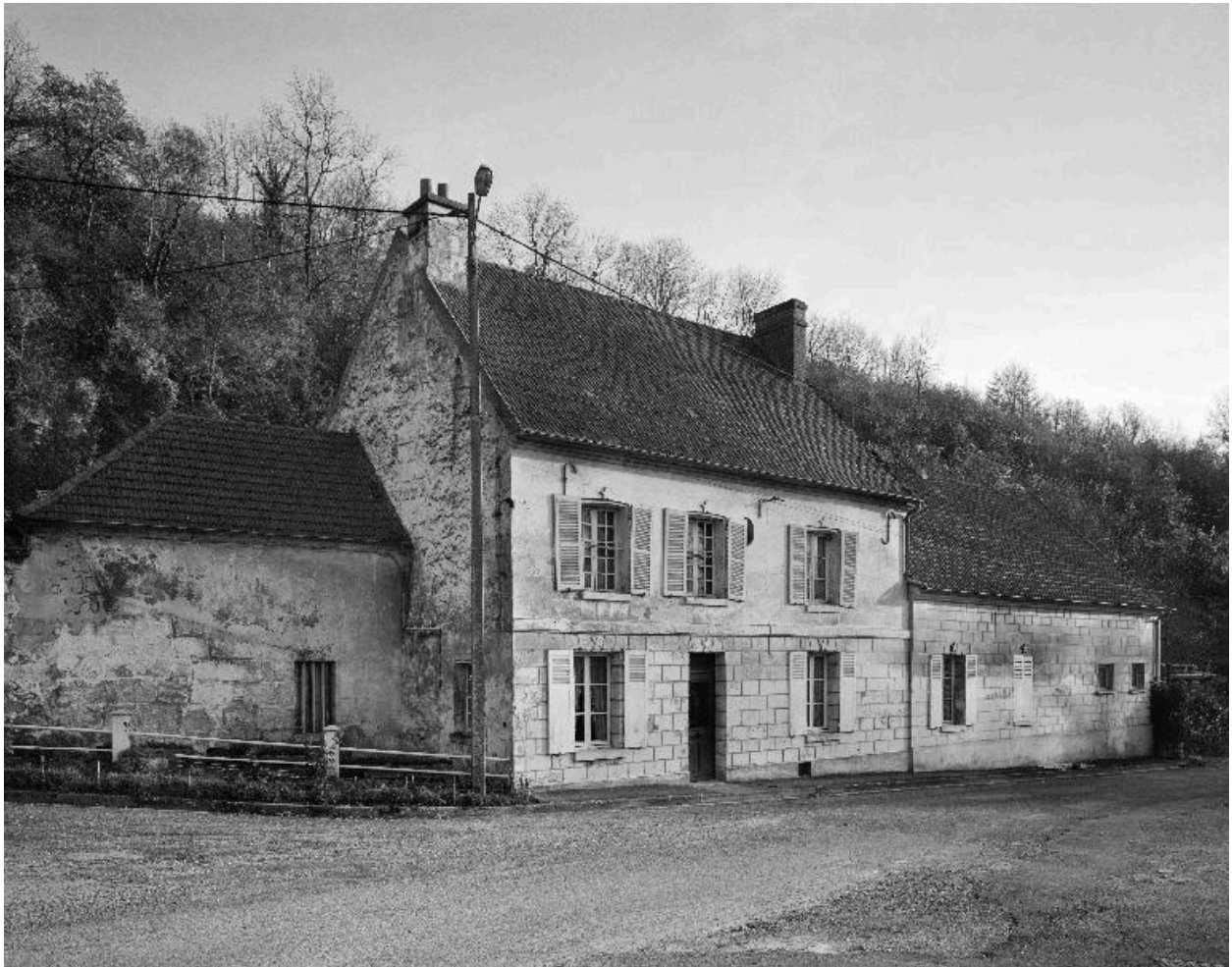
Vue de l'élévation antérieure du logement.
