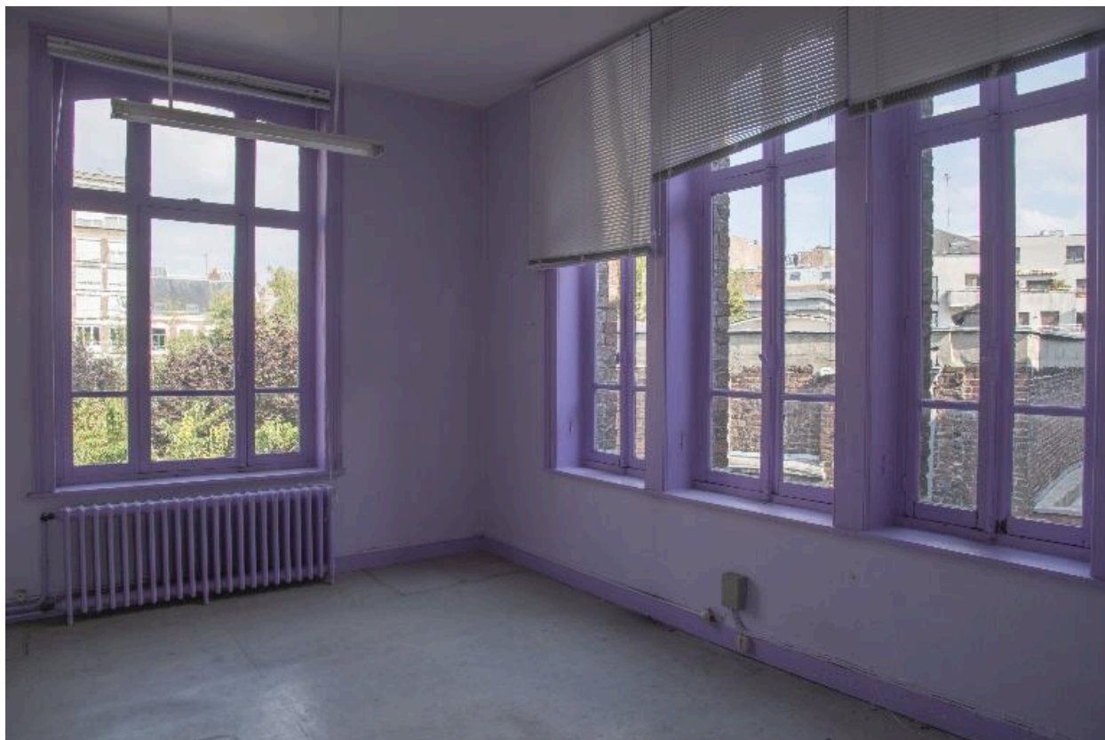
Bâtiment administratif, premier étage : vue de la pièce nord.
