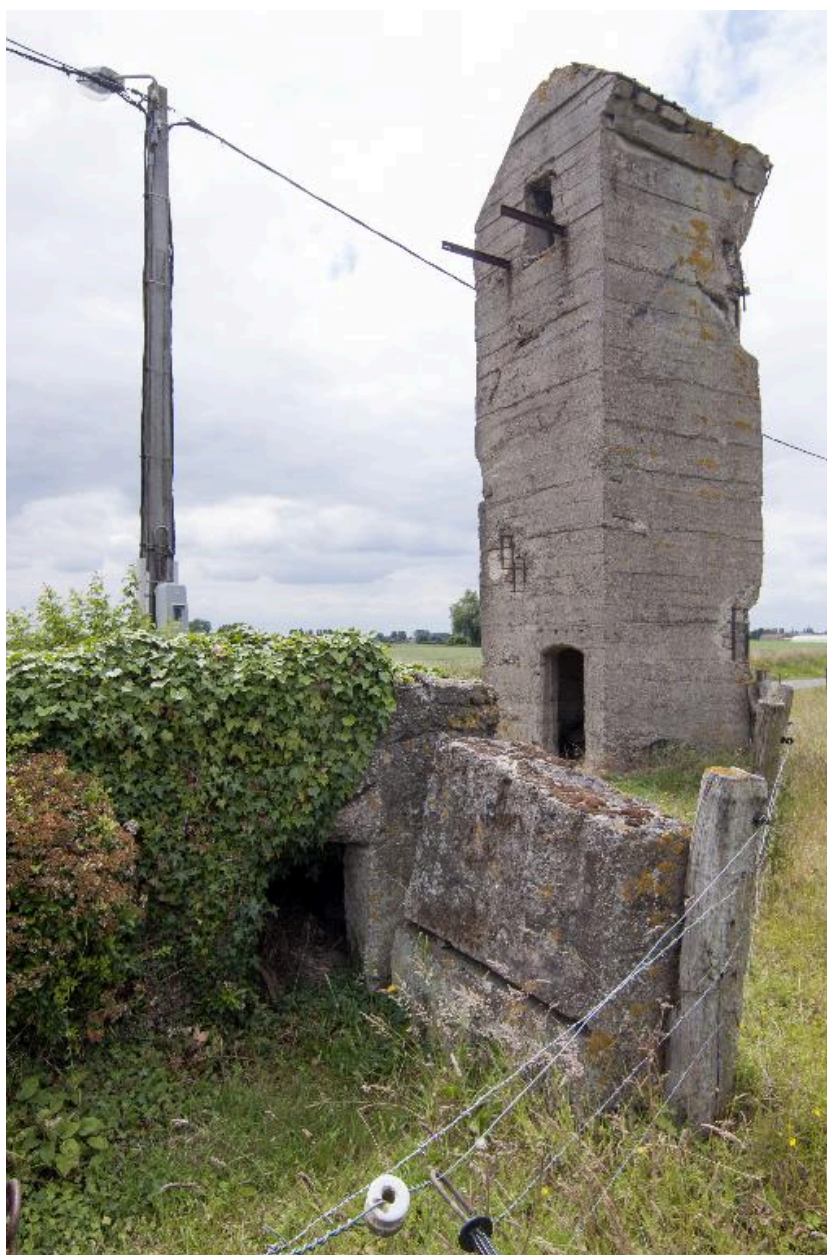
Vue générale des deux casemates, vers l'ouest
