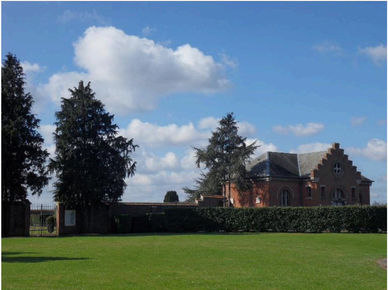
Vue de situation depuis le nord-est.
