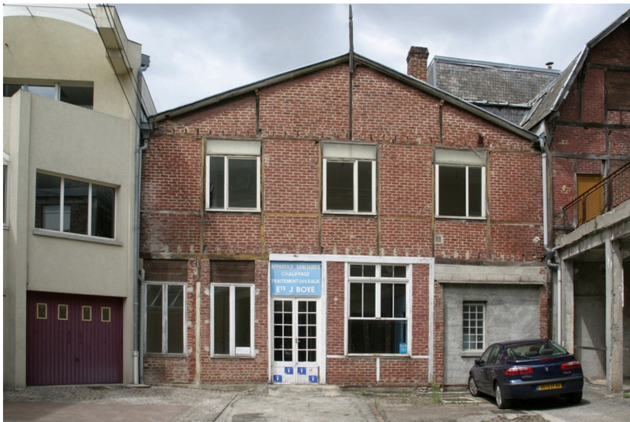
Façade antérieure des anciens magasins et ateliers.
