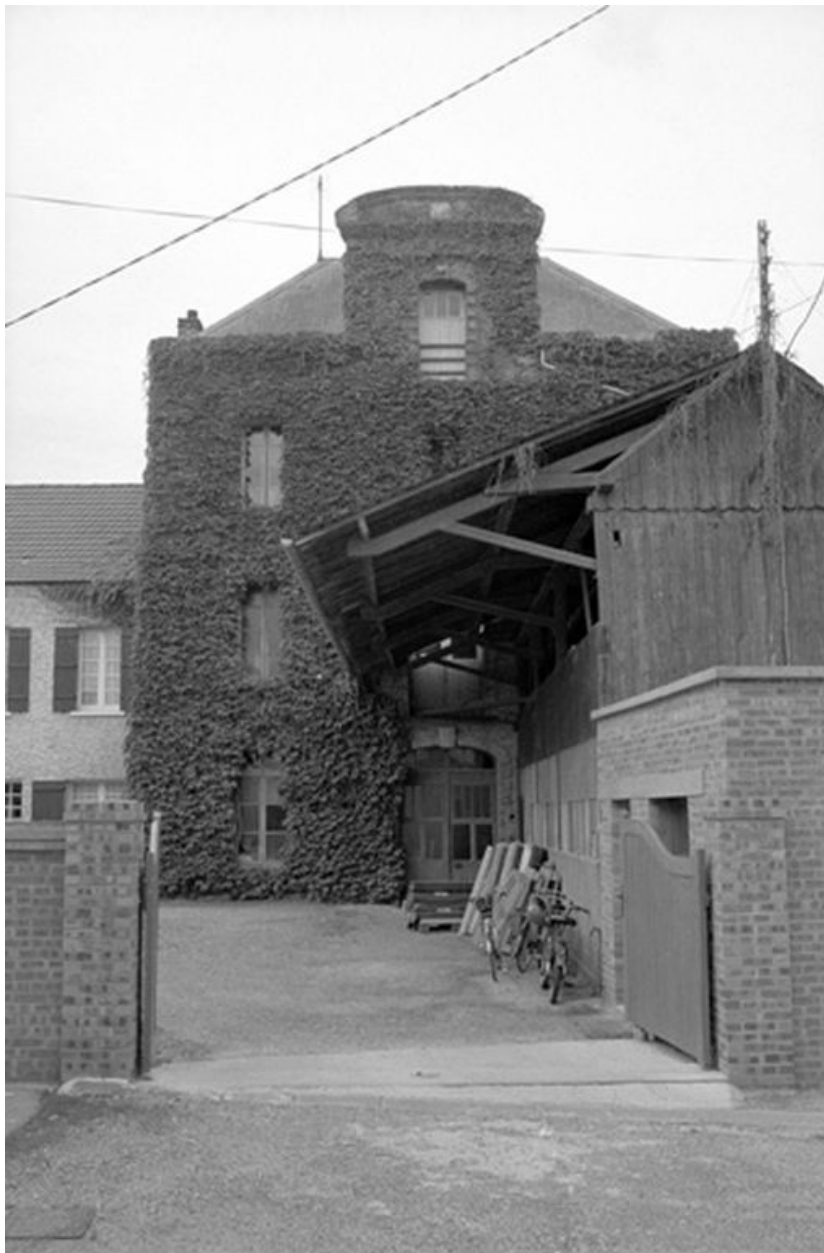
Bâtiment d'eau, élévation antérieure.
