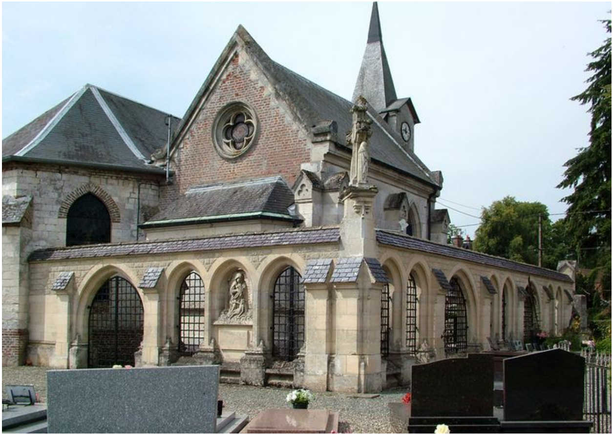
Vue de trois quarts arrière de l'enclos funéraire et de la chapelle.
