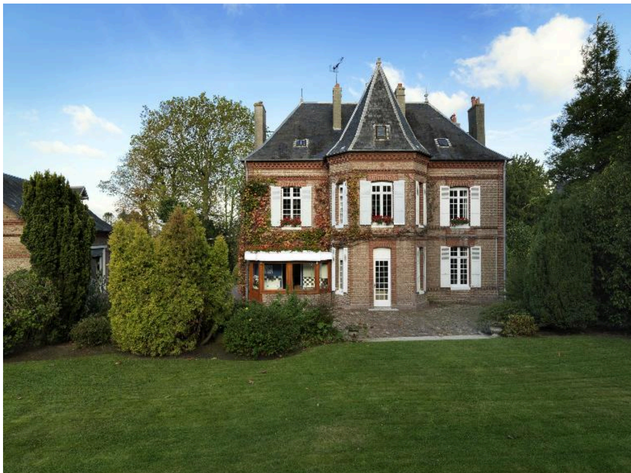
Vue de la façade postérieure.
