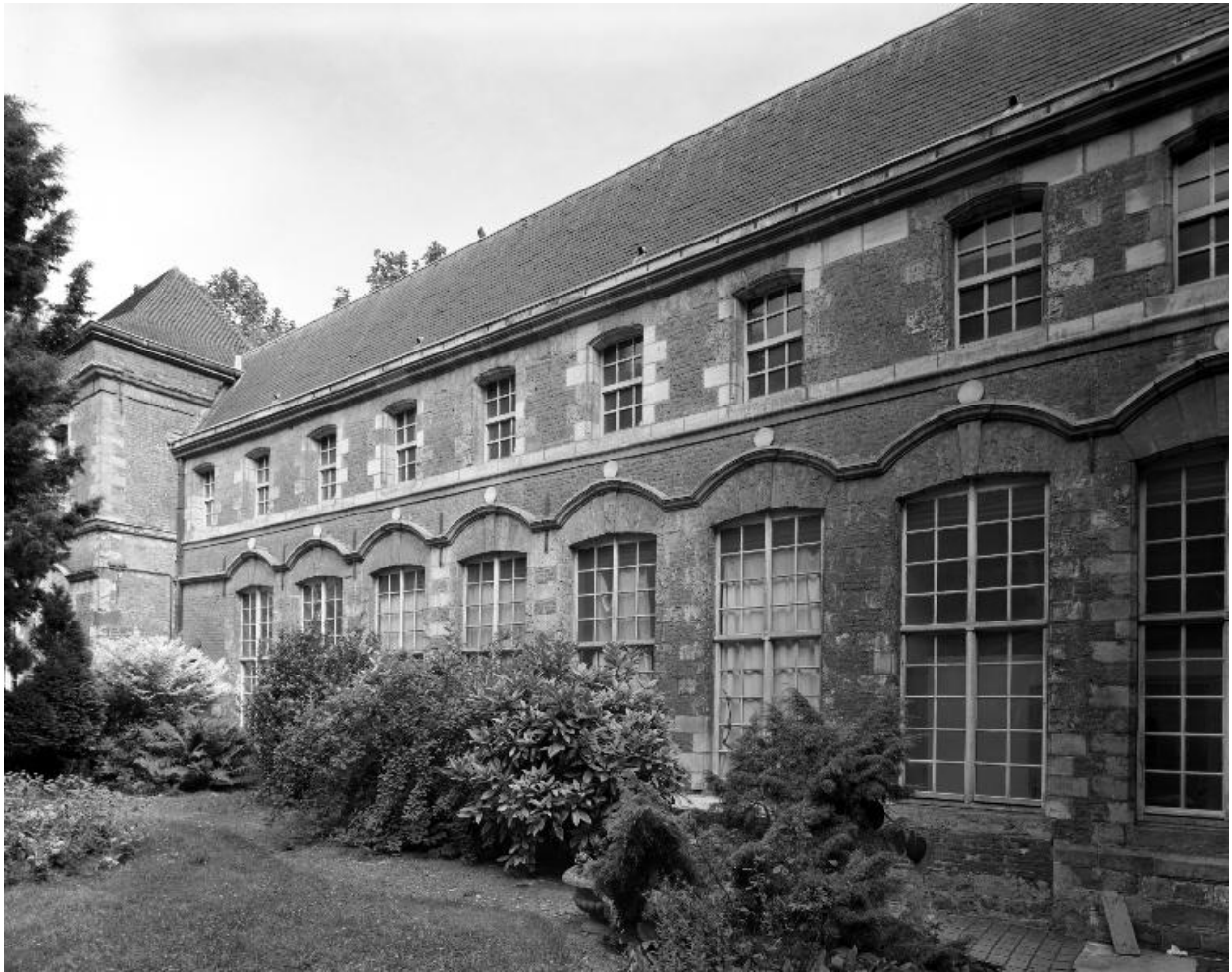
Bâtiment bordant le côté nord de la cour d'honneur, élévation sur la cour.
