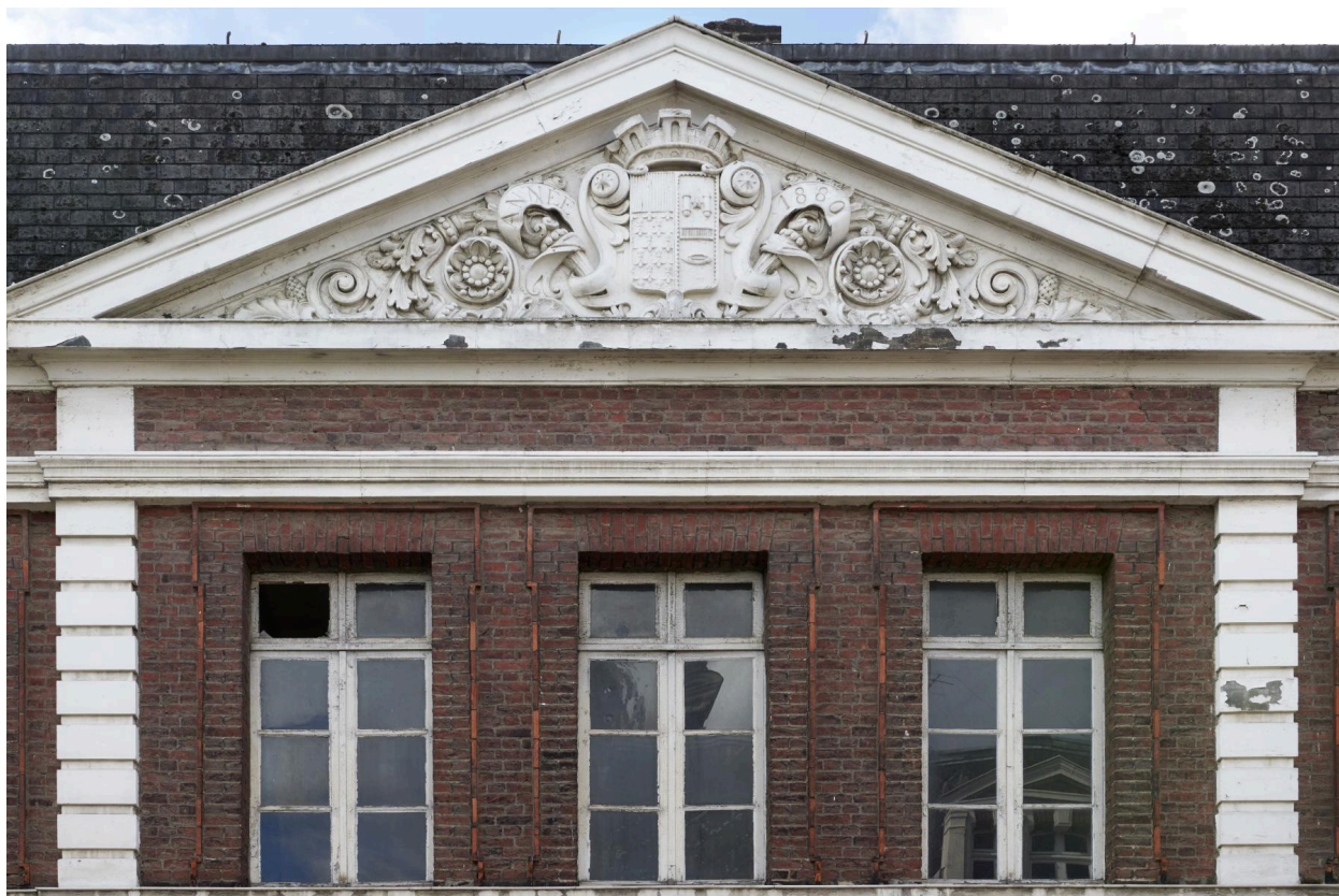
Détail du fronton représentant les armoiries de la ville de Roubaix et pilastres.
