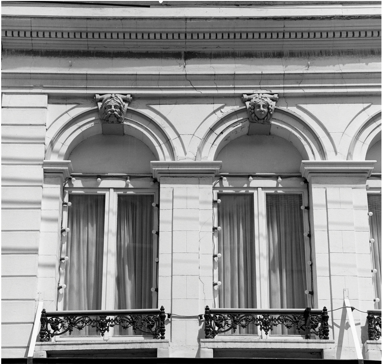
Élévation antérieure : détail des sculptures du premier étage (I, II).
