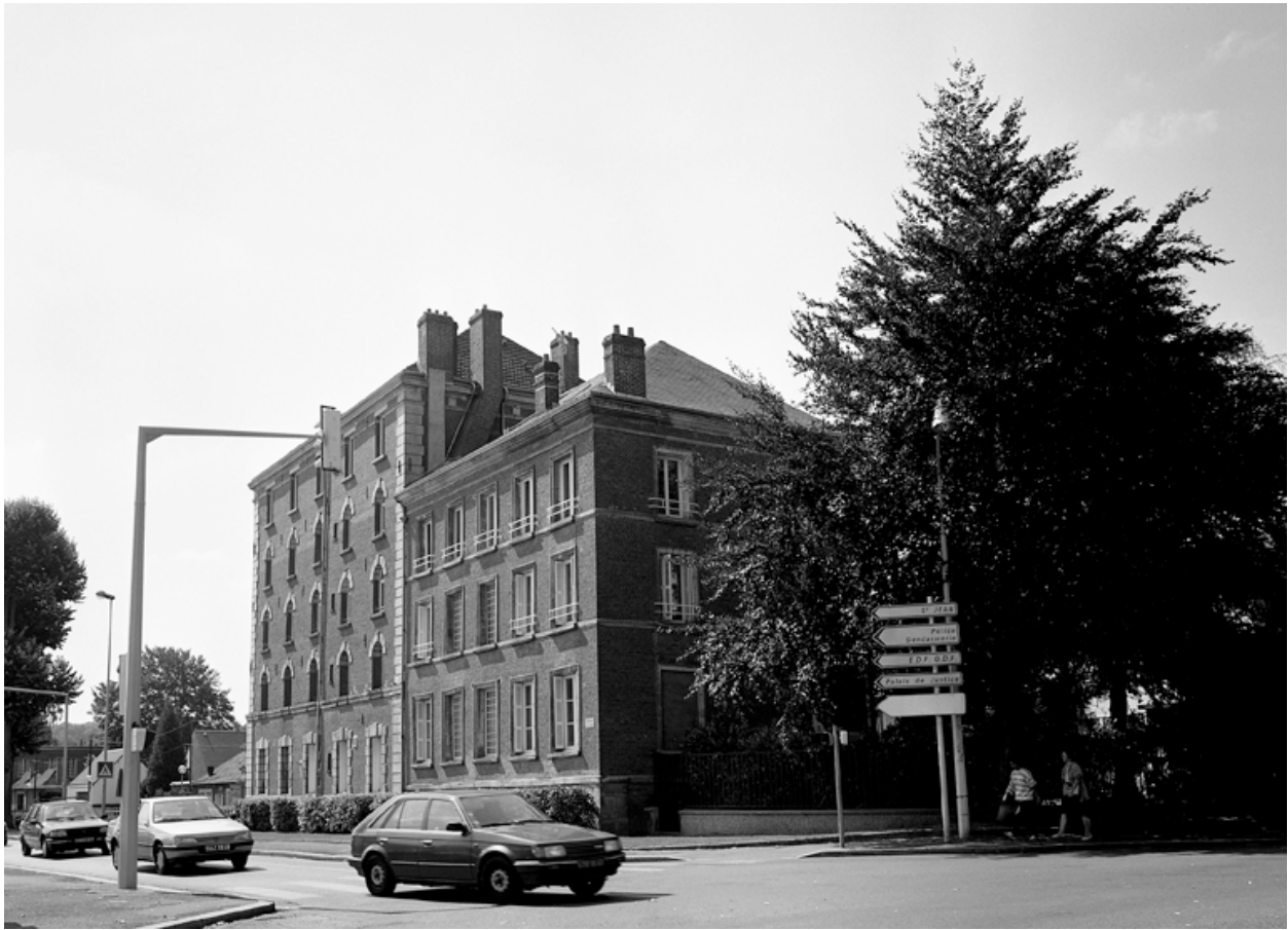
Vue latérale est-ouest.
