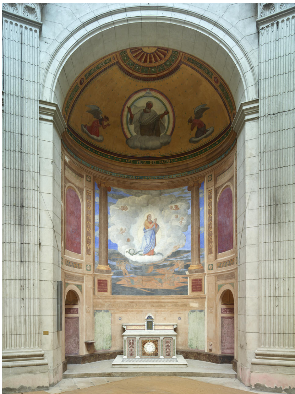
Vue générale après restauration.
