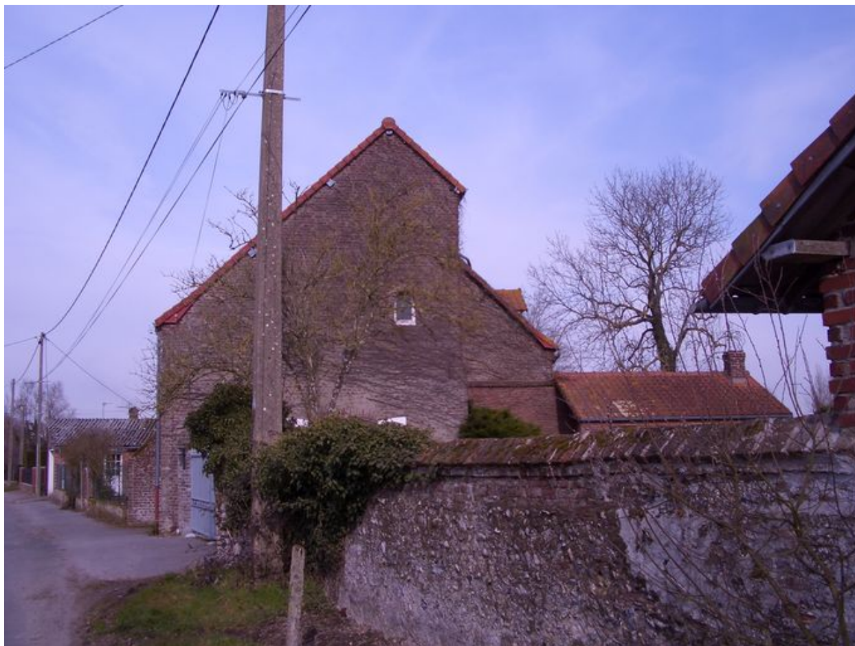
Vue du pignon sud.
