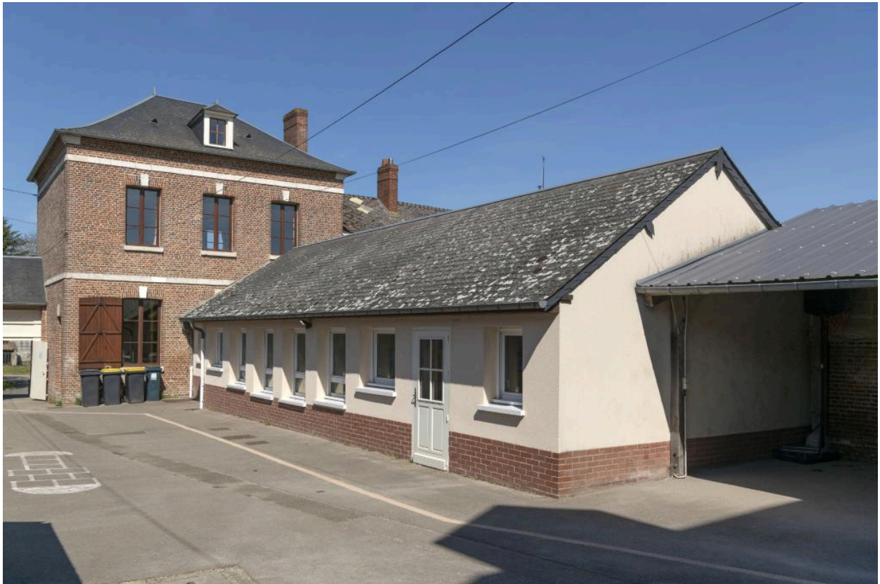
Cour de l'école avec nouveaux bâtiments et façade sud de la mairie-école.
