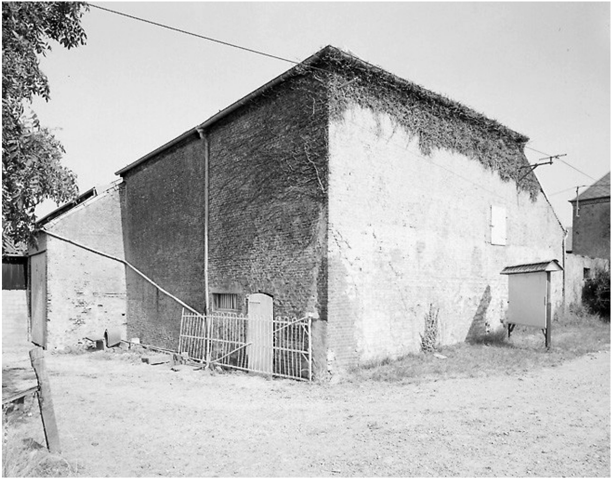
Vue de l'élévation postérieure des bâtiments d'exploitation de l'aile sud.
