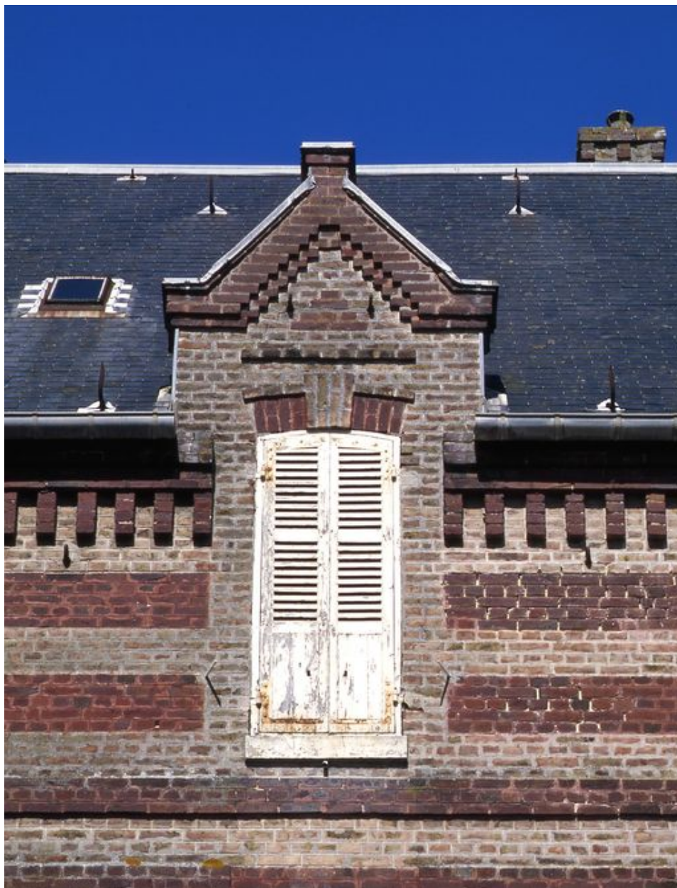
Détail d'une fenêtre de lucarne à fronton-pignon.
