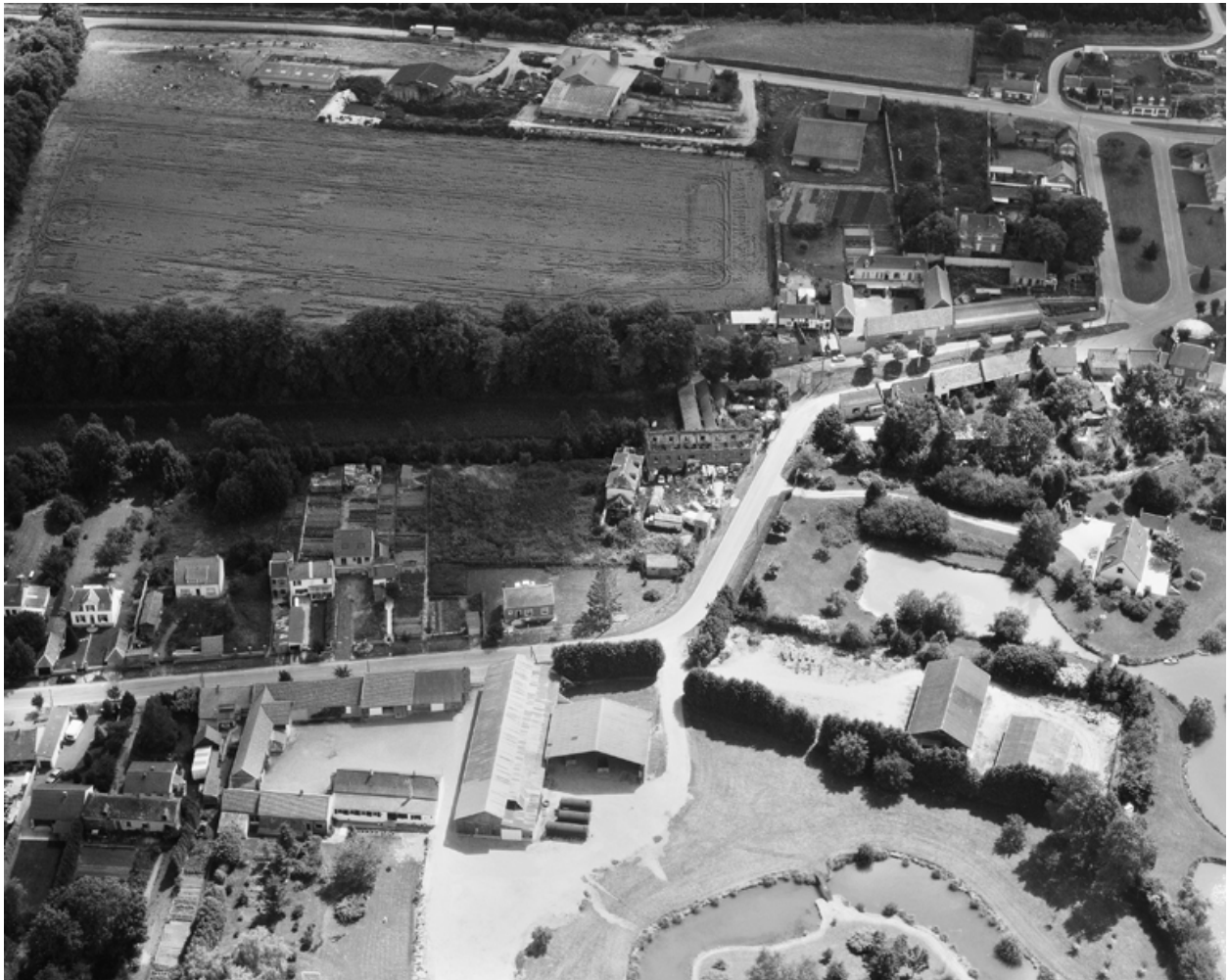
Vue aérienne, flanc ouest.
