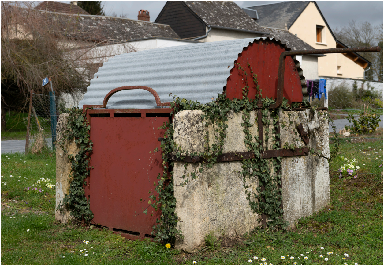
Puits de la rue du Beau-Bois (devant le n°9), vue depuis le sud.
