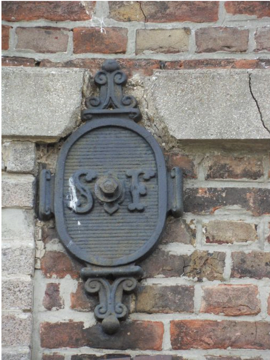
Maison de contremaître, 81 rue Docteur-Jean-Martin, détail sur l'ancre de façade (SF).
