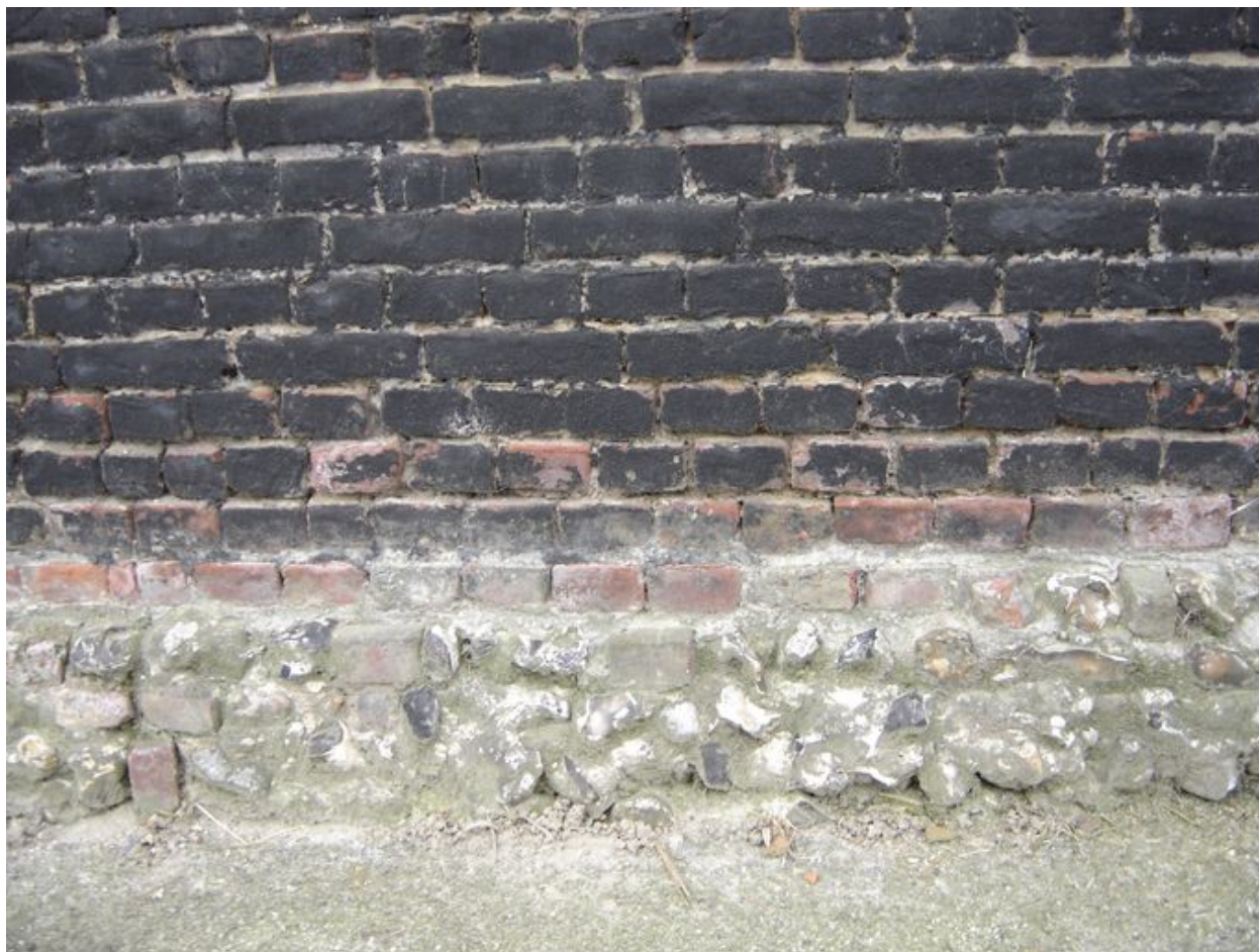
Détail du solin de la grange.
