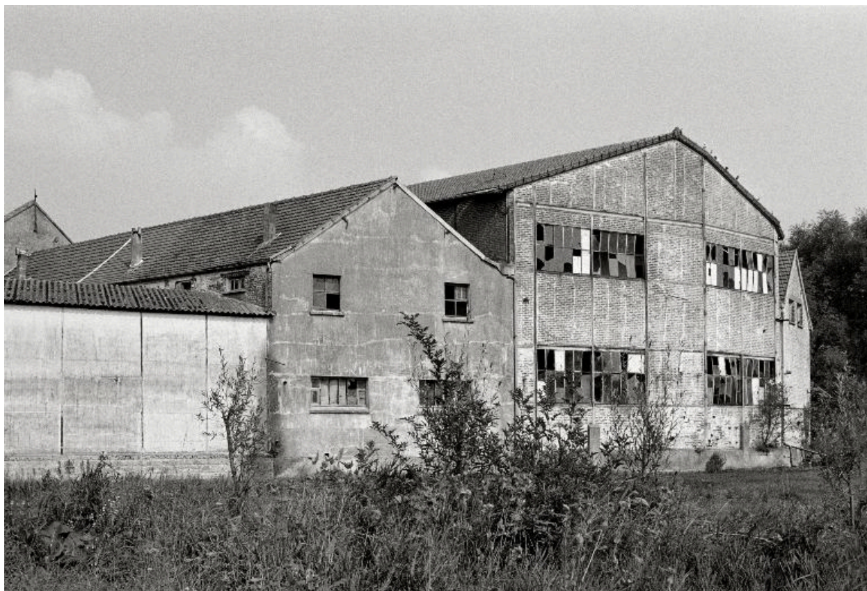
Ateliers de fabrication, élévations postérieures.
