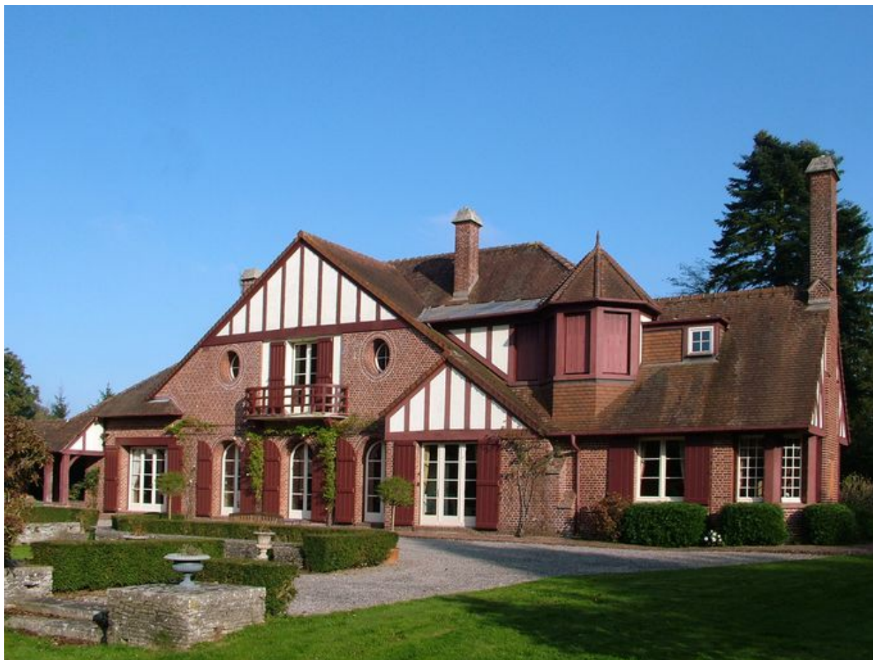
Façade postérieure du logis, de trois-quarts.
