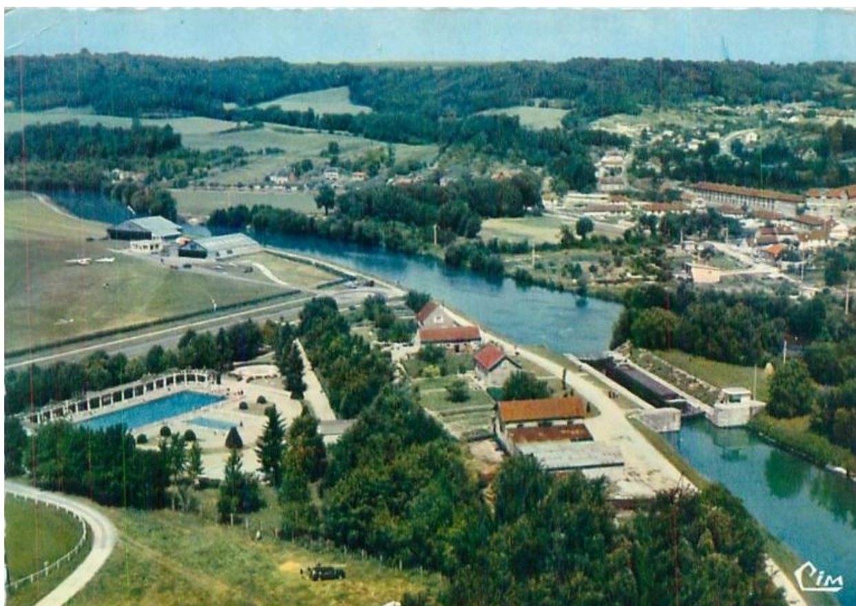
Vue aérienne de la piscine de Soissons avant la construction de la piscine couverte, au niveau du stade, vers 1960, carte postale (coll. part.).
