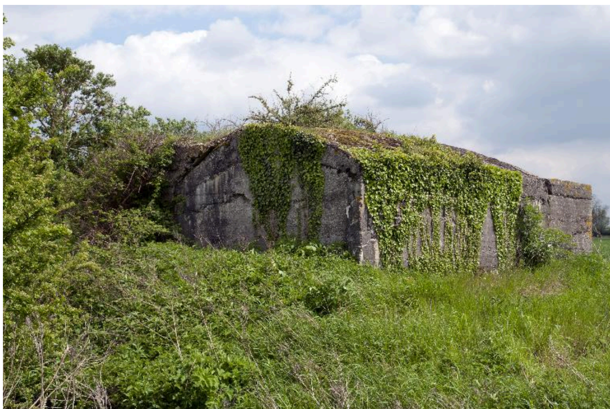
Bâtiment A, vue de trois-quarts vers l'est
