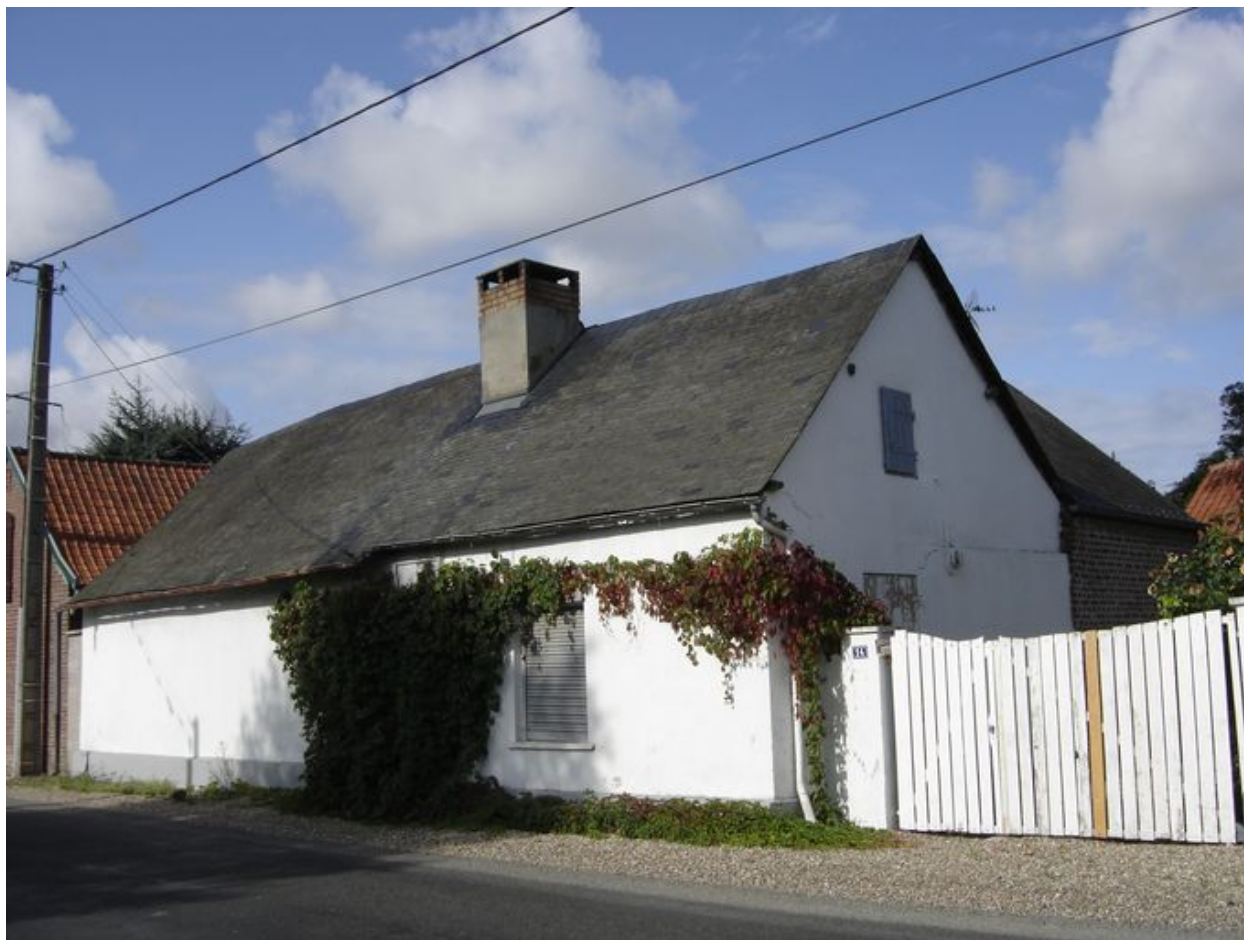
Vue du logis sur rue.
