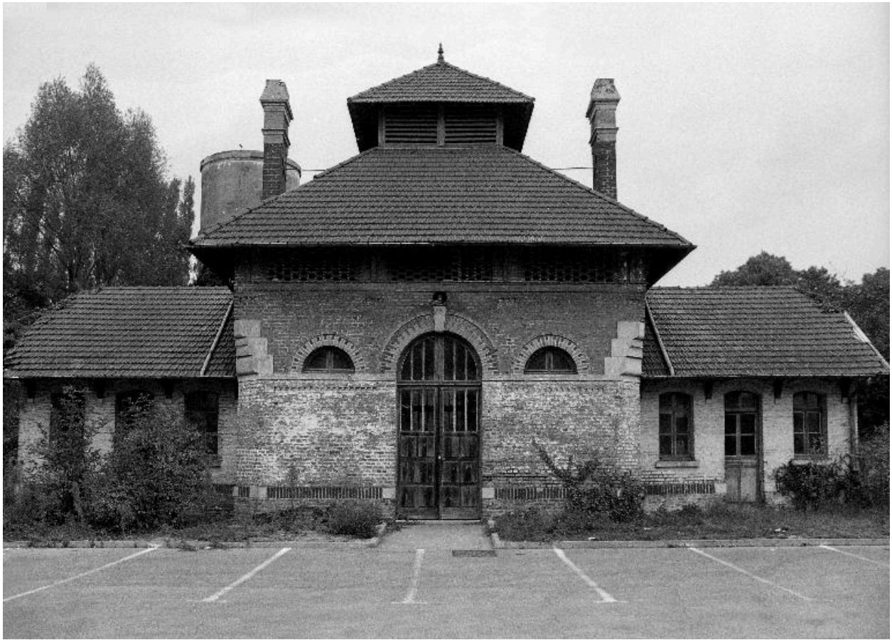
Magasin de commerce, dépendance (blanchisserie), élévation antérieure.
