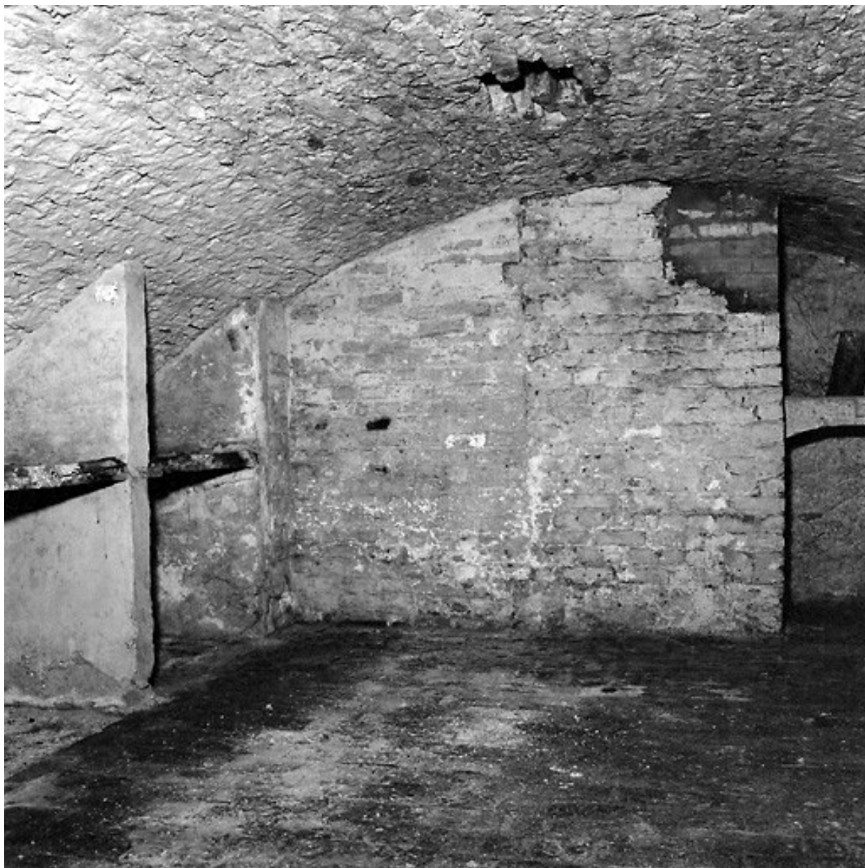
Sous-sol, cave arrière : mur sud.
