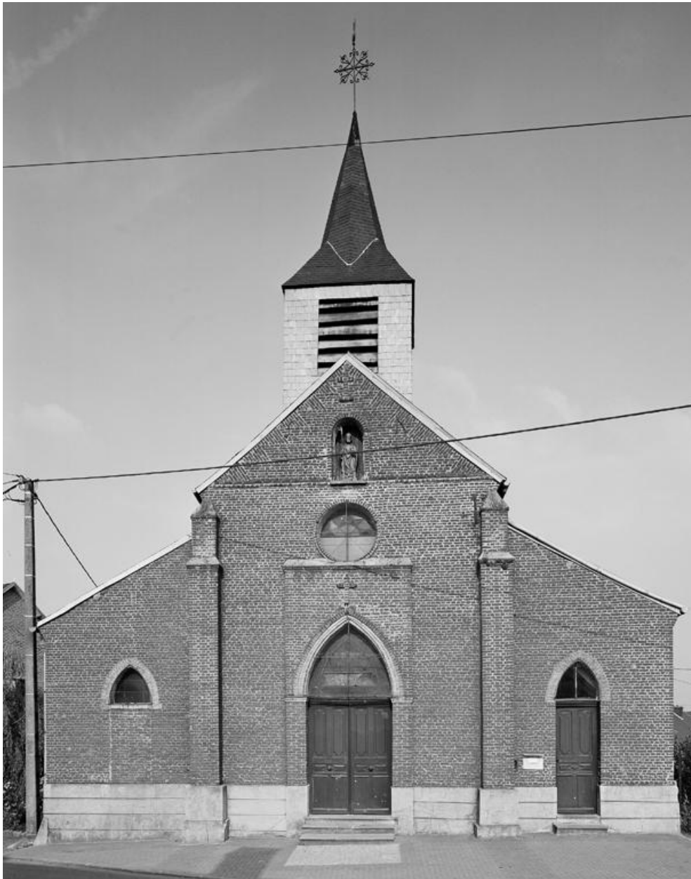
Vue d'ensemble de la façade.
