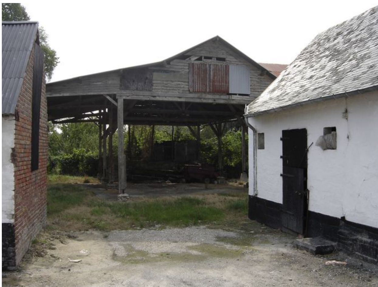
Vue du hangar en fond de propriété.
