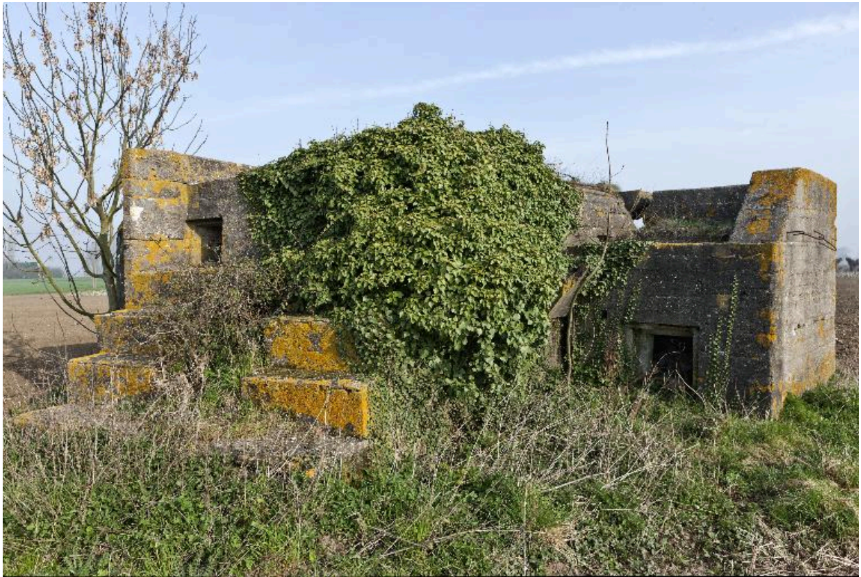
Vue générale, vers le nord-ouest
