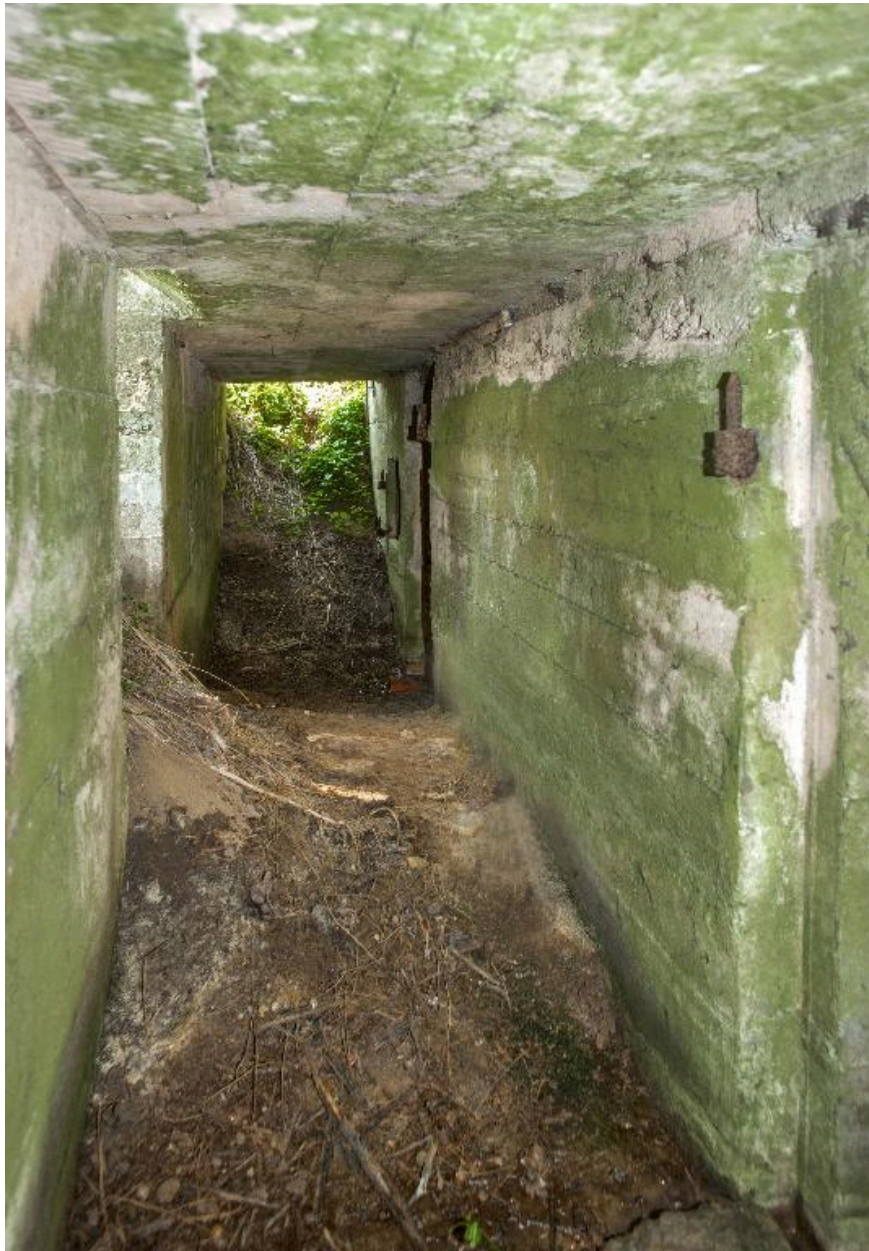
Couloir de distribution, vers le sud
