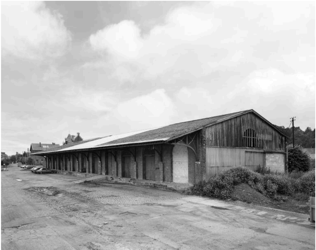
Vue de la halle de chargement.
