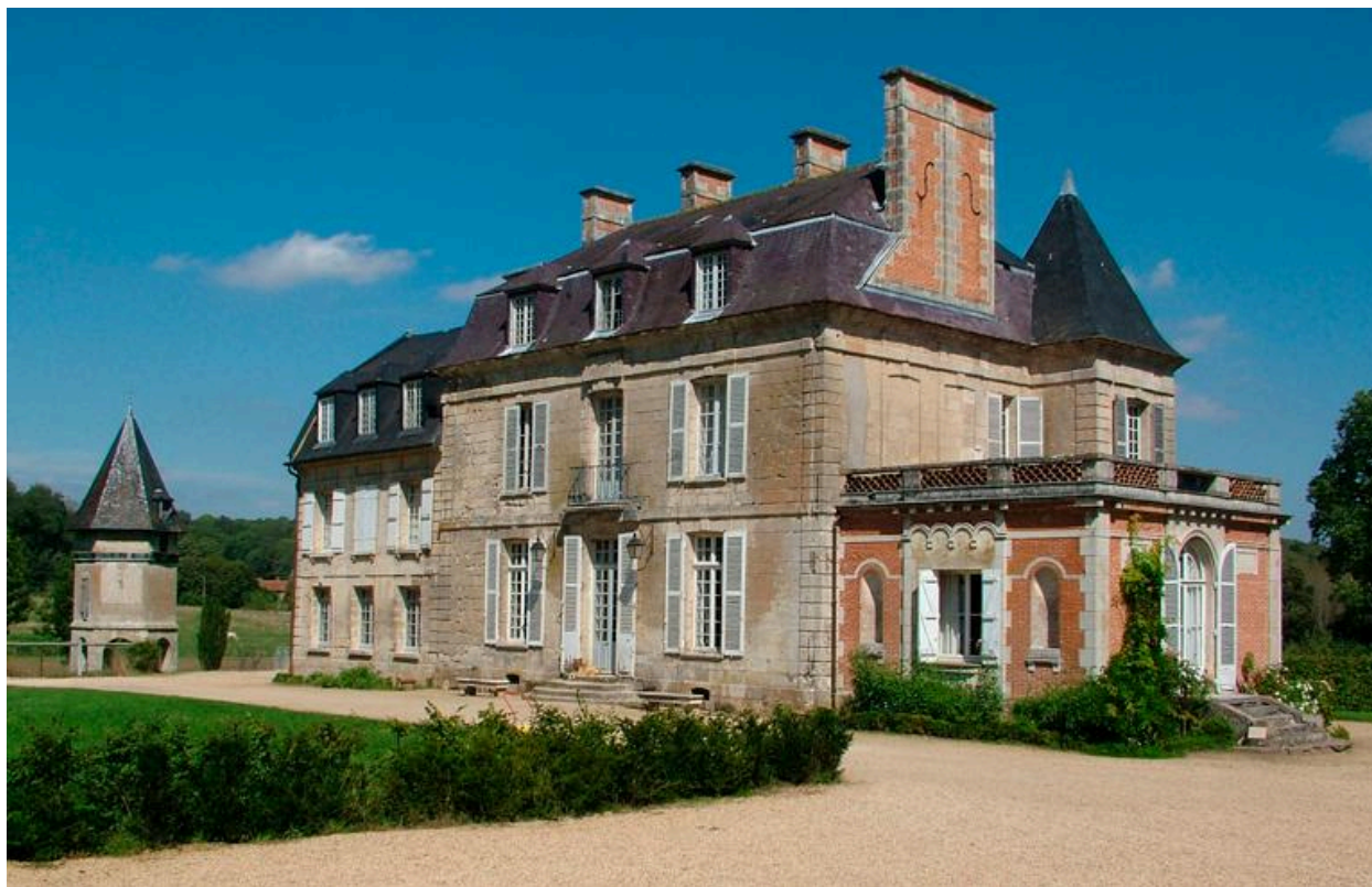
Vue de l'élévation antérieure.
