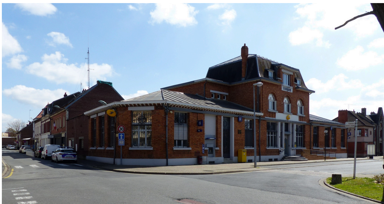
Vue générale depuis le nord-ouest.
