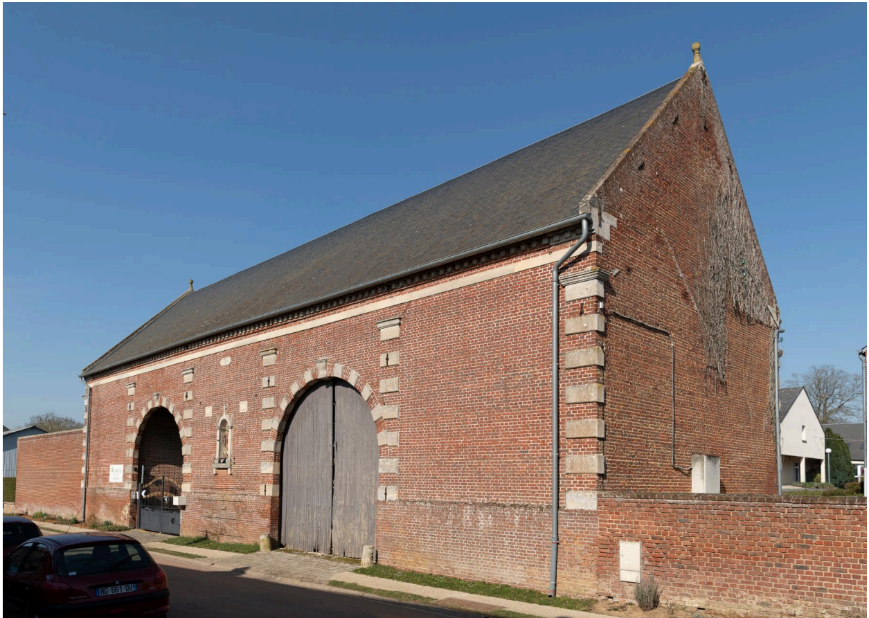
Foyer Saint-Nicolas (ancienne ferme), n°35 de la Neuve-Rue, vue prise depuis le sud.
