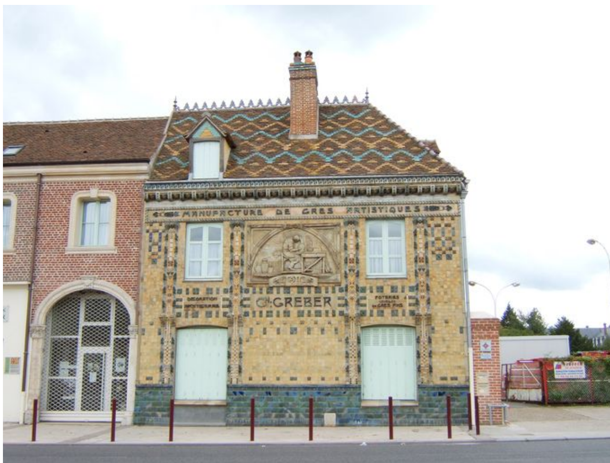
Façade sur rue de la Manufacture Gréber.
