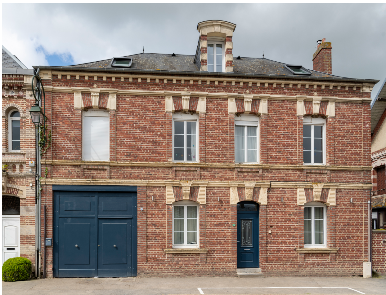
Demeure, n°6 de la rue de la Mairie, vue depuis l'est.
